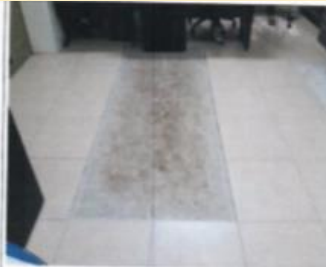
Picado de piso
