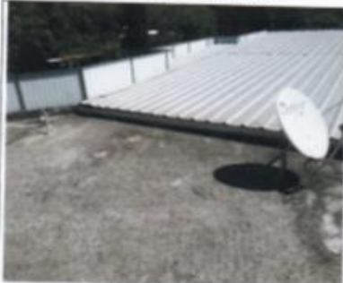
Construcción de Muro y canalización de Aguas Lluvias
