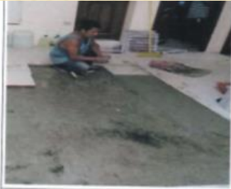
Colocación de Cerámica Nueva
