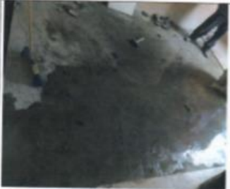
Levantamiento de Cerámica Existente
