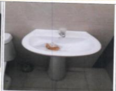
Instalación de Llaves FV
